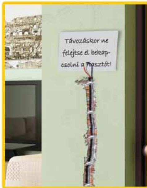
A felszerelt vagyonvédelmi rendszerek nagy többségét a festés befejezése után tervezik meg és telepítik
